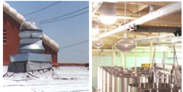
(a) 외부 (b) 내부 그림 2. 라이트 파이프 시스템의 설치 사례
