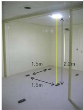
그림 13. 실내 바닥면 주광 조도 측정 상황
