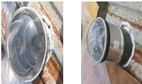
(a) 라이트 파이프 집광부 (b) 라이트 파이프 측면 그림 9. 실물모형에 설치된 선 파이프
