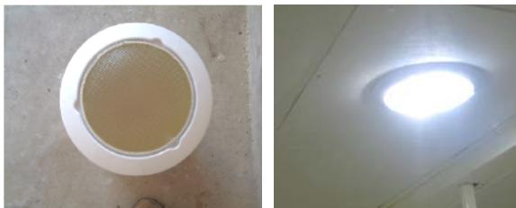
(a) 채광부(디퓨저) 장치 (b) 시공후 채광부(디퓨저) 그림 10. 실물모형에 설치된 라이트 파이프 채광부(디퓨저)
