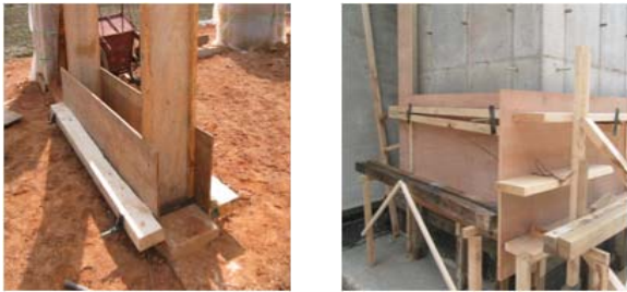
a) 일반 흙다짐 거푸집 b) 흙다짐 합벽 거푸집 그림 4. 공법에 따른 거푸집 비교
