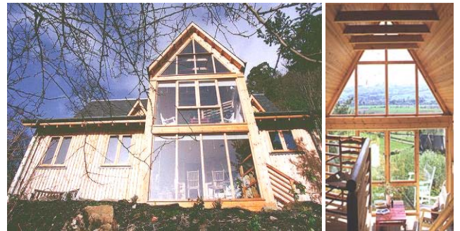
그림 15. 스코틀랜드 목조주택외부, 계단실 통창이 자연채광 및 보온역할, 가이아그룹 그림 16. 목조주택 내부, 무독성재료, 숨쉬는 집
