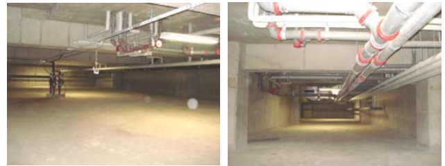
(a) 피트 전단부 전경 (b) 피트 후단부 전경
