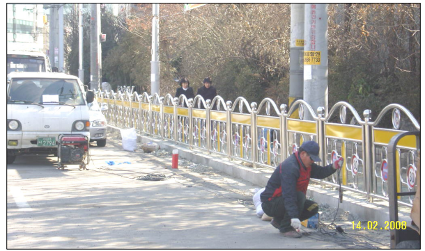
사진 6. 안전헨스 설치
