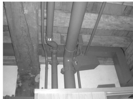
〈그림 20〉 천수각 내의 감시카메라와 스프링클러 배관
