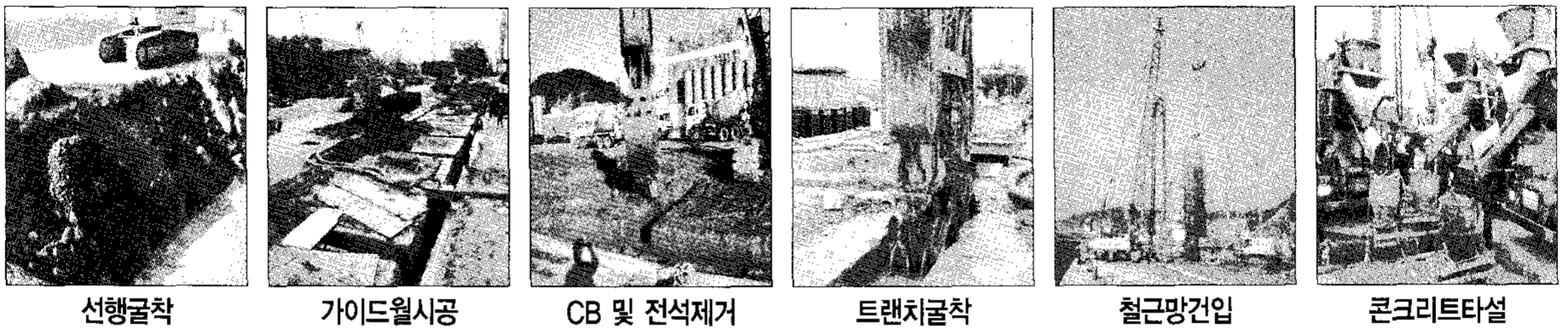
사진 1. H형 자립식 지중연속벽 시공
