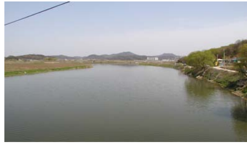
FIGURE 22. 곡릉천 최하류로부터 5번째 구간 상류방향으로의 전경
