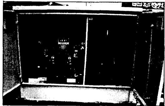
그림 3. 지상 변압기 설치(3상 300(kVA)) Fig. 3. Installation of Pad-mounted Tr(3Φ300(kVA))
