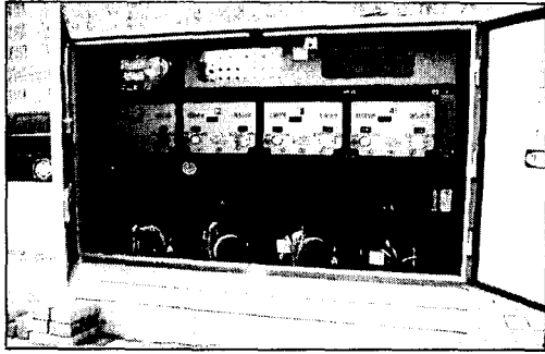
그림 5. 지상 개폐기(25.8(kV) 가스개폐기) Fig. 5. Installation of Switches(25.8(kV) GIS Switches)
