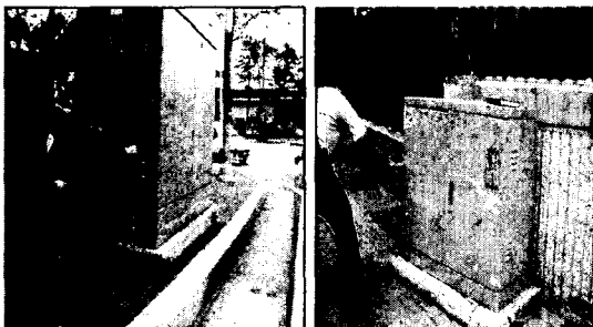
그림 9. 고양시, 천안시 인근 지상변압기 침수 높이 Fig. 9. Flood hight of Pad-mounted Tr at Goyang and Cheonan
