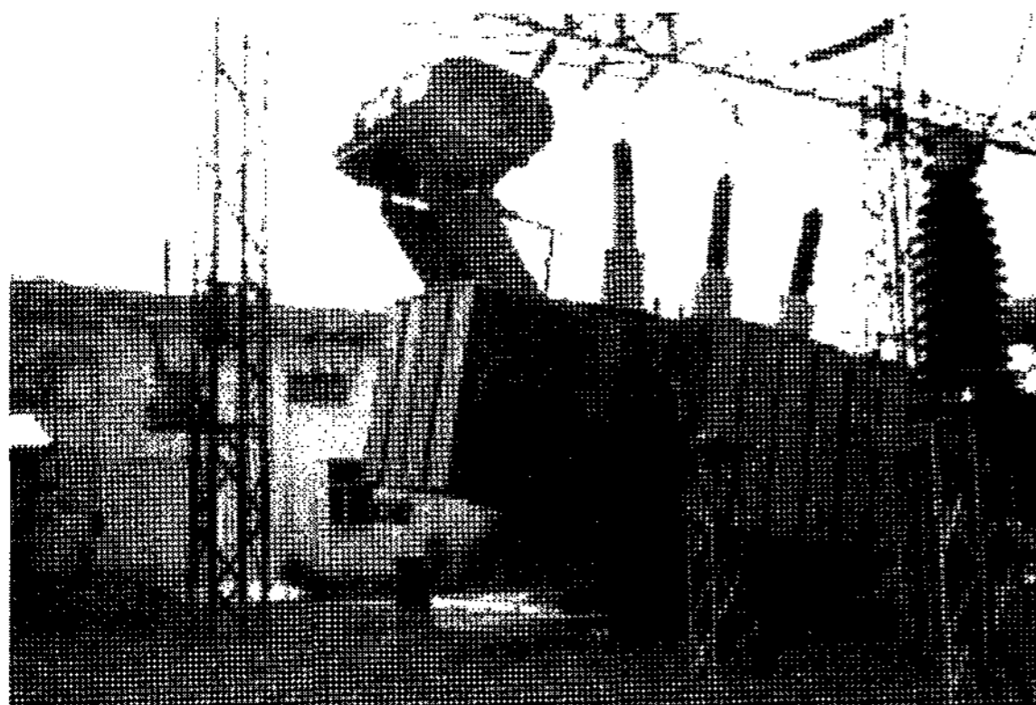
〈그림 1〉 변압기의 지진피해 사례
