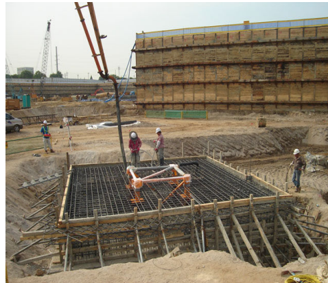
(b) 콘크리트 타설
