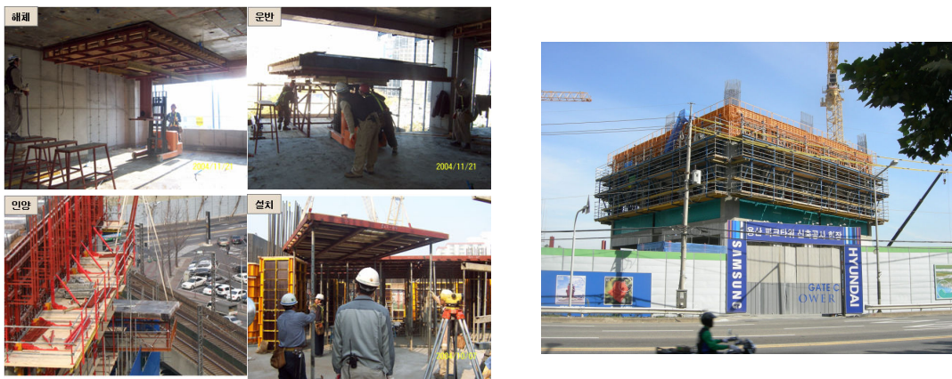
그림 10. 테이블 폼 및 ACS 설치 사진
