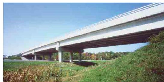
그림 8. NEBT 거더를 사용한 경간장 38.1m의 Jetport Interchange 교<sup>12)</sup>
