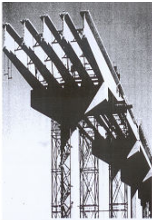
그림 10. 분절 PSC 거더교의 시공
