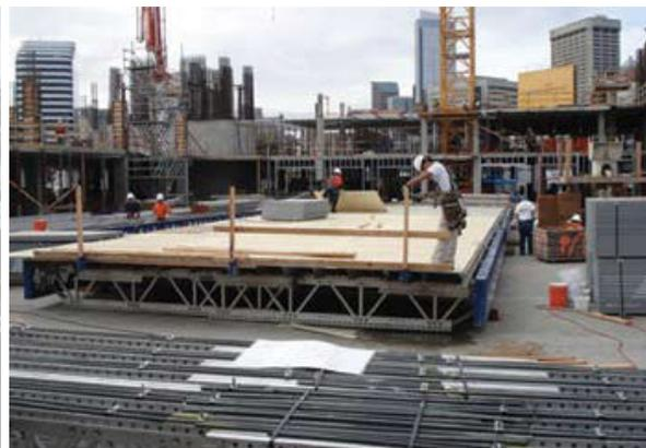
그림 8. 트러스-플라잉 데크(truss-flying deck) 시스템 (출처: Koczyński, 2008c)
