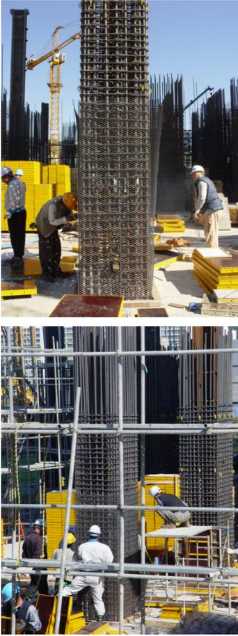
사진 5. 메탈라스 현장조립 및 시공 모습
