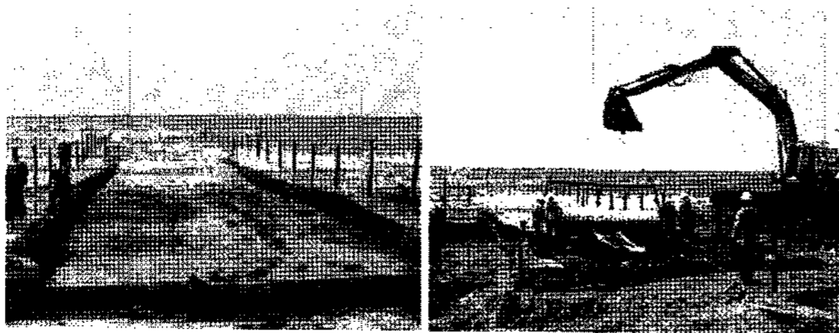
③ 앵커(anchor) 튜브 충전 ④ 튜브의 포설
