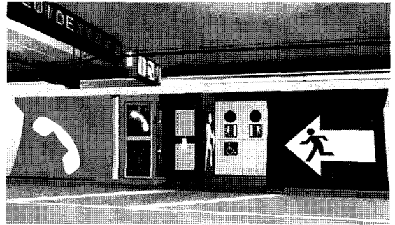
[그림 12] 피난대피통로 입구부 전경
