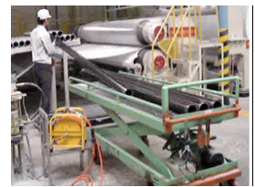
스틸코어 설치준비 작업개선 후
