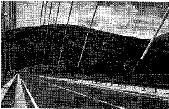
그림 6 사장 케이블에 MR 감쇠기가 설치된 Dr. Franjo Tadjmann 교 (출처: http://www.dywidag-systems.com )
