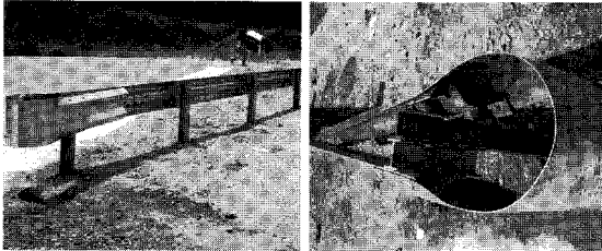
그림 6. 기존 단부처리시설 설치사진
