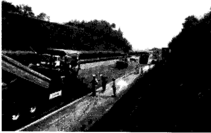
그림 7. 온도조건을 30℃ 저감한 현장시공 예(JH조반자동차도)
