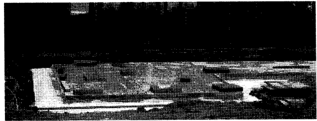
그림 5. 바닥단열재 설치
