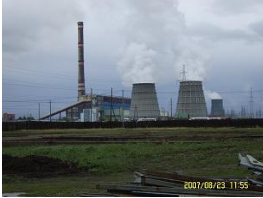
부지 인근의 석탄 화력발전소
