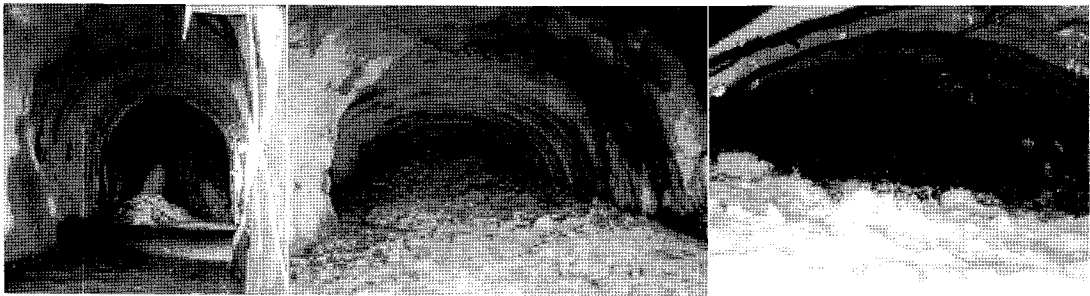
a) 1시간 후: 25 m 3 /min b) 3일 후: 80 m 3 /min c) 13일 후: 15,000 m 3 /min
