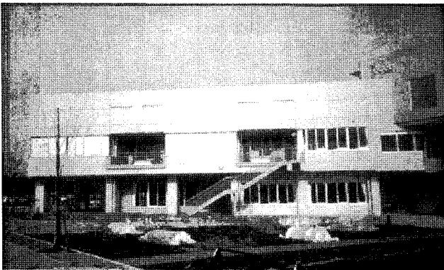
사진 5. 이니하노(いには野)소(57)의 2층 특별교실 외부계단
