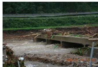
Fig. 5 이목정 소하천 내 교량
