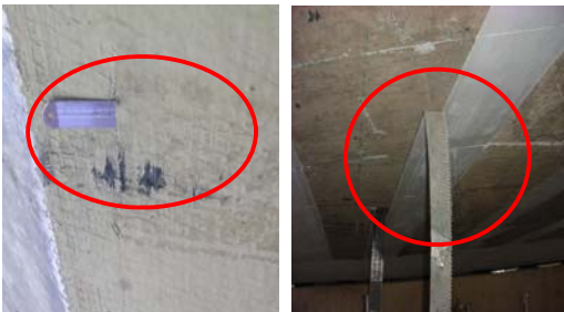
탄소섬유의 박리 (박리된 탄소섬유에 자가 삽입된 모습) 탄소섬유의 박리 (손쉽게 떨어지는 탄소섬유)
