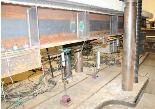
(a) 게이지 및 LVDT 부착
