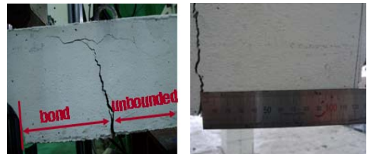
(d) Detail of Concrete splitting failure
