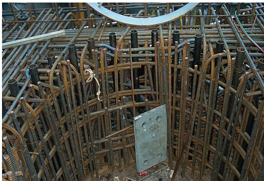
Fig. 1 철근의 겹이음 시공
