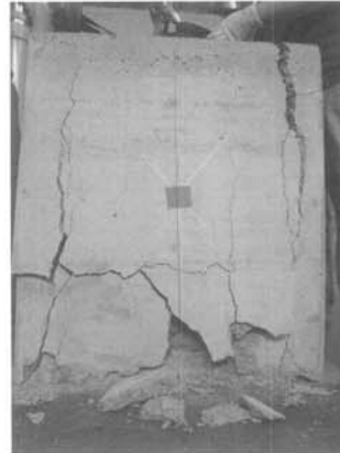
그림 20. 하부 콘크리트 바닥판의 압괴에 의한 파괴
