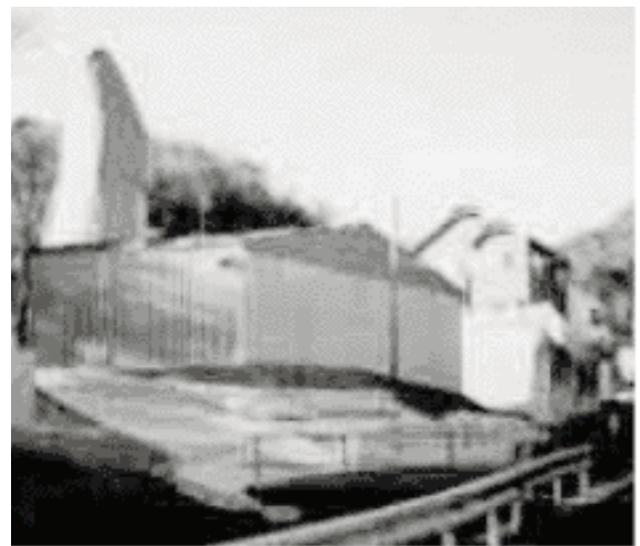
[그림 6] 굴착을 위한 방음하우스 설치(일본)
