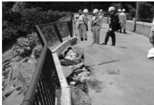
그림 2. 이와테/미야자키지진 시 댐 정상부 피해현황(이시부찌댐)
