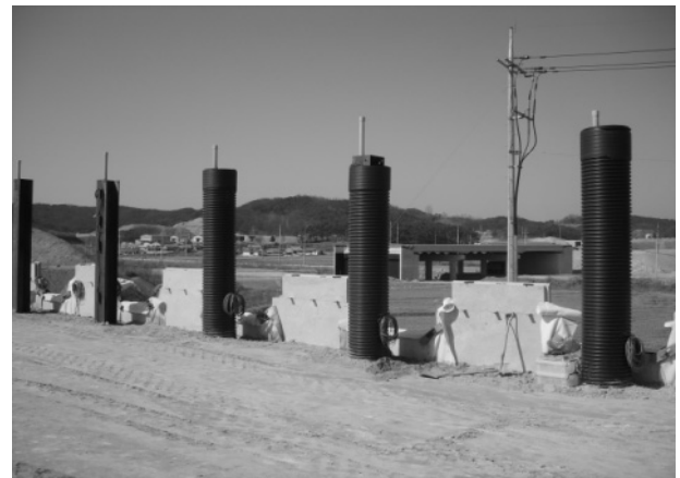
그림 14. Sheath 관이 설치된 H-pile 시공 전경 사진
