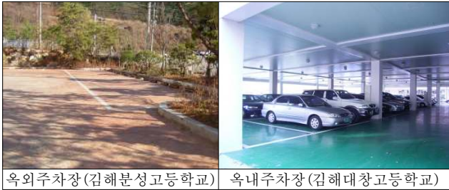
그림 5. 주차장 설치 사례
