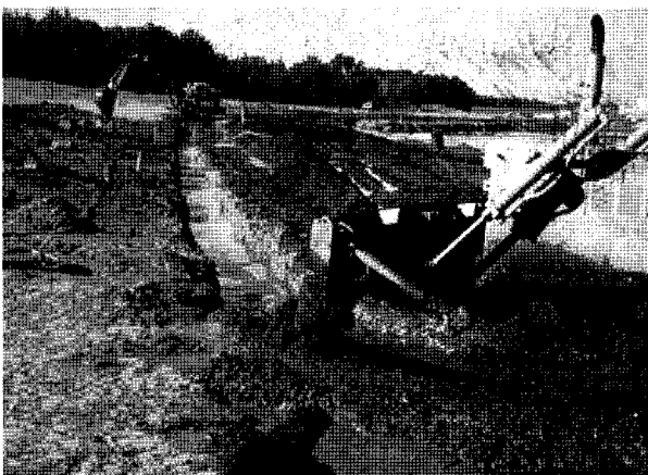
(a) 트렌치 굴착 및 뒤채움 전경
