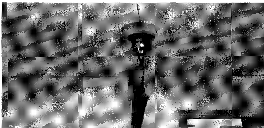
<그림 14> 벨로우즈 커버를 열감지기 설치면에 밀착한 모습
