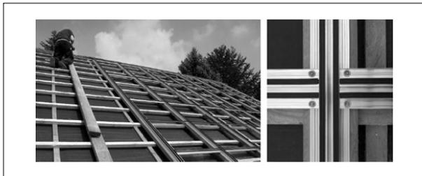
Fig. 7 지붕 마감 후 모듈 고정위한 프레임 설치
