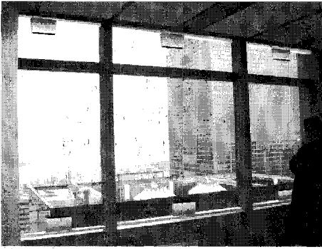
(시공된 모습/각각의 조명기구에 모두 하우징을 제작하여 씌우는 방법으로 빌딩안으로 빛의 유입을 차단)
