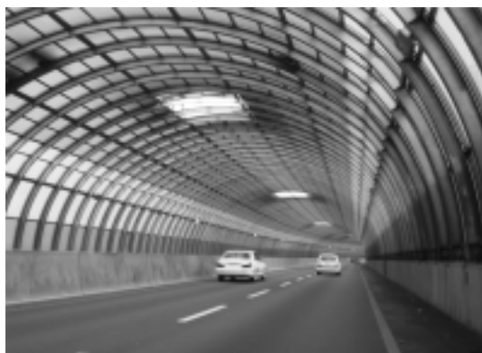
Fig. 10. 방음터널에 의한 도로소음 대책.
