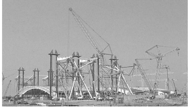
〈그림 9〉 Roofing material in place prior to erection. 설치를 위해 준비된 지붕재
