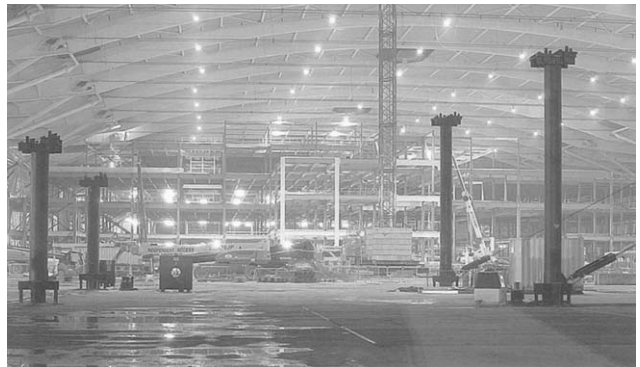
〈그림 10〉 Central section clad and prestressed, May 2004. 중앙단면의 마감재와 긴장, 2004년 5월
