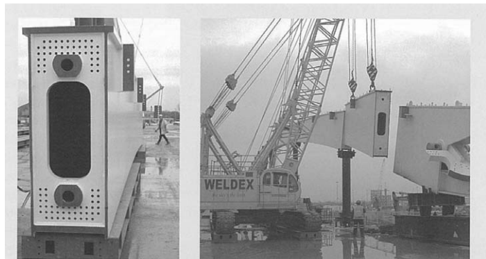
〈그림 23〉 Close-up of shear key.
