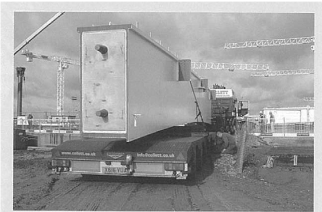
〈그림 8〉 Rafter section arriving on site.
