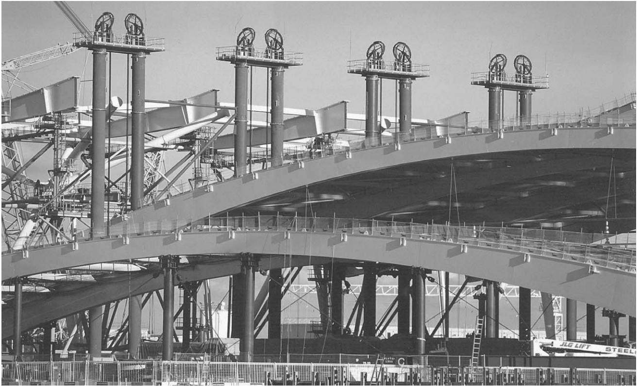
〈그림 11〉 Jacking of roof elements. / 지붕구조재의 인양
