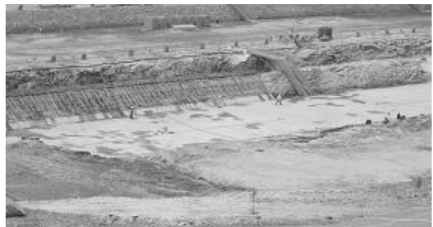
기초 콘크리트 타설 및 접지망 포설
