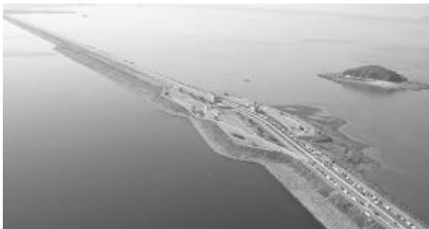
공사 착공전 전경
