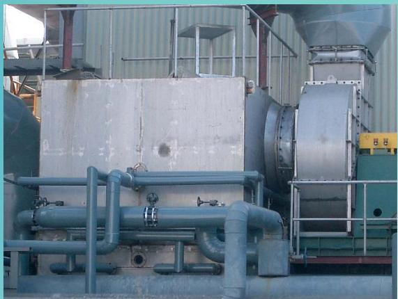
이 사업은 한국 노스케스코그의 TMP 1, 2호기 Reboiler에서 발생되는 스팀( $13\text{톤}/\text{h}$ ,  $1\text{kg}/\text{cm}^2\text{g}$ )을 스팀 MVR(Mechanical Vapor Recompressor)을 이용하여
