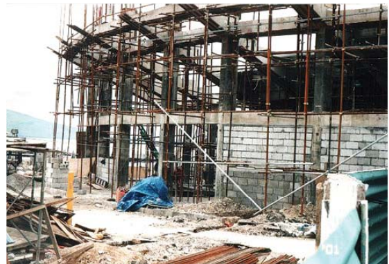
[사진 7] 리조트시설 신축공사 현장
