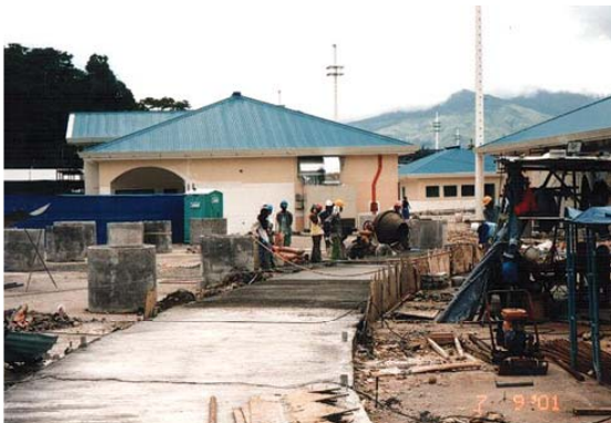
[사진 6] 콘크리트 도로 포장 공사
