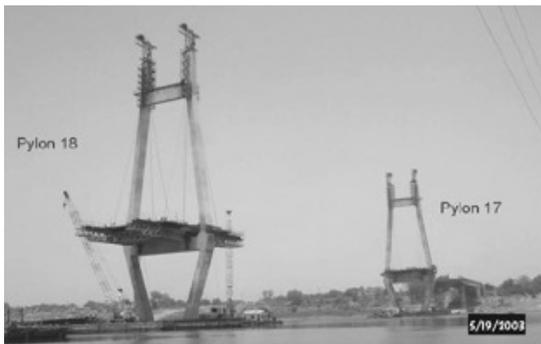
[그림 14] Form Traveller를 이용한 보강형 시공
