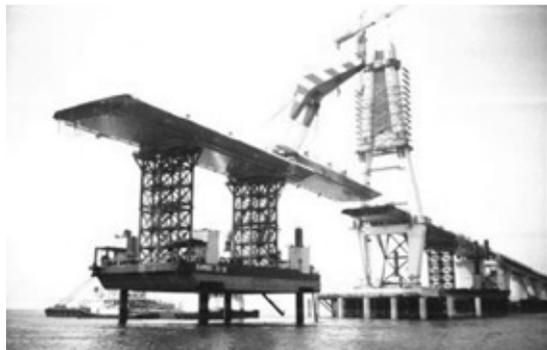
[그림 7] Jackup Barge를 이용한 대블럭 가설 공법
