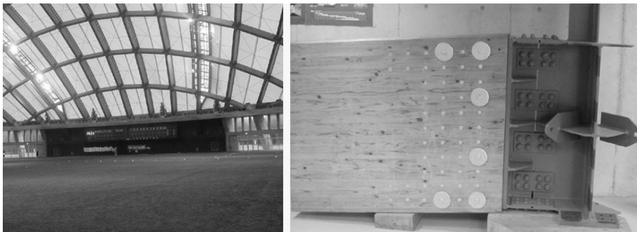
그림 9. 일본 미야자키현(宮崎県) 미야자키시(宮崎市) 소재의 고노하나 돔(木の花 dome). 천장 구조에 삼나무 집성재를 약 7000본 사용한 단층 아치 구조로서 지간 거리(span) 100 m를 넘는 대규모 돔
