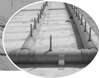
◀ 산소공급장치 발효조에 공기를 공급하기 위해 공기공급관에 산소공급장치를 설치하여 유기성폐기물의 발효능률을 향상시킴
