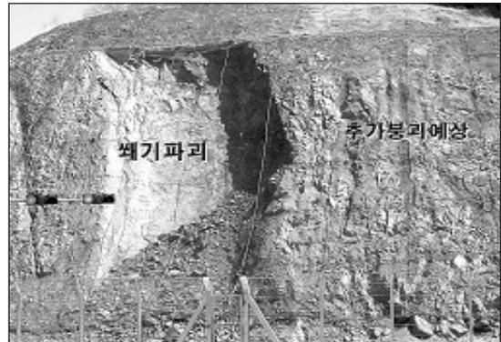
그림 3. 기시공된 비탈면 및 추가붕괴 위험지역 측정의 어려움
