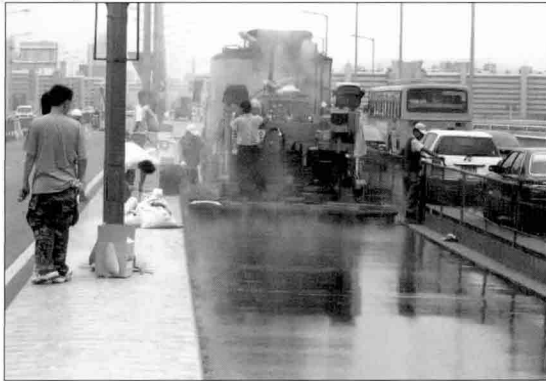
[사진 8] 구스아스팔트 혼합물 시공
